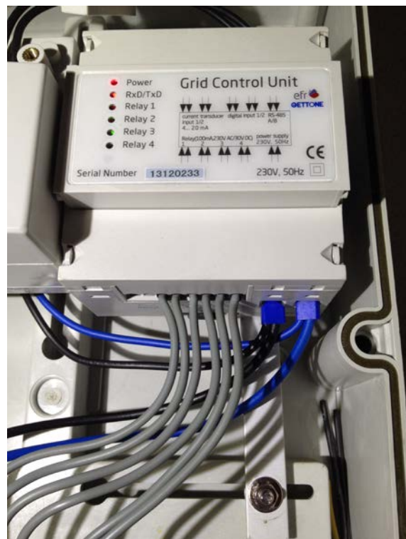
Belegung der Relais 2-4 (60-30-0) und Versorgungsspannung für SGHC/GCU
