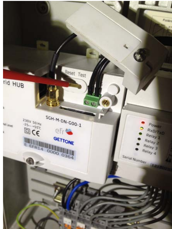
Eisman-Testablauf durch Druck auf die Testtaste auslösen und wirksame Drosselreihenfolge analog zum FRE- Testwandlereinsatz ins Portal eintragen
