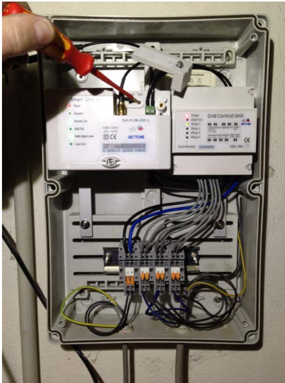
Versorgungsspannung anlegen, Reset-Taste drücken, Verbindungsaufbau abwarten
